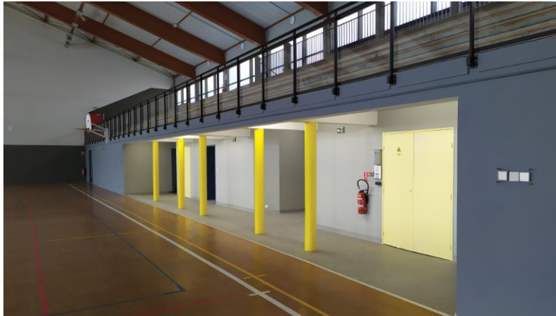
Rénovation du Gymnase - 2019
