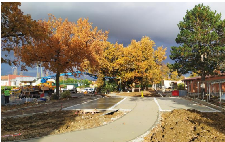
Travaux de requalification – décembre 2019
